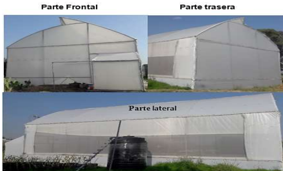
Figura 1 Invernadero tipo cenital con ventilación natural localizado en la Universidad Autónoma Chapingo
